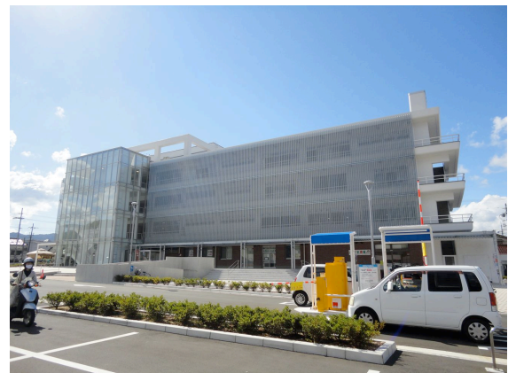
施設周辺は広々としていて、駐車スペースも充分。BM拠点としても活動がしやすい。
